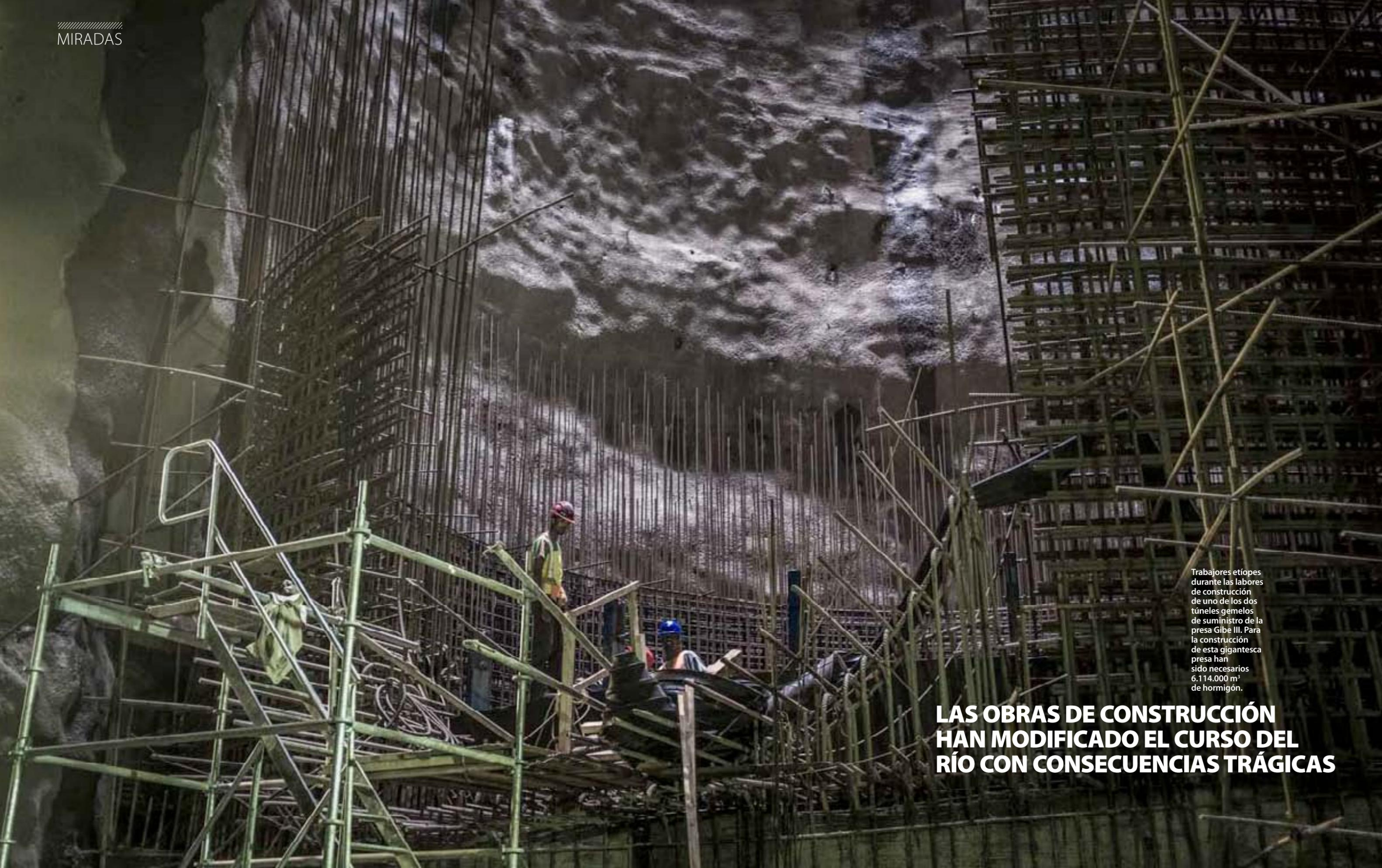
Trabajos etíopes durante las labores de construcción de uno de los dos túneles gemelos de suministro de la presa Gibe III. Para la construcción de esta gigantesca presa han sido necesarios 6.114.000 m<sup>3</sup> de hormigón.
